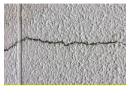
外壁のひび割れ★★★★
