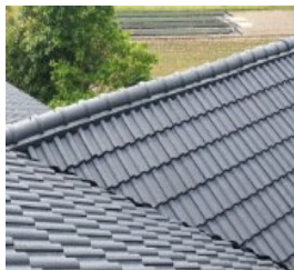
屋根塗装のみ
